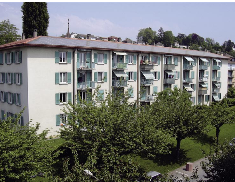
PV-Anlage auf einem Mehrfamilienhaus in Basel (44 kW p )
