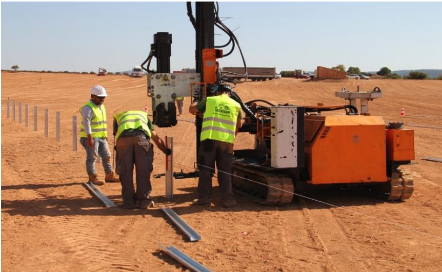
Montage de la structure porteuse, photo du 17.10.2017 (photos: Smartenergy Invest AG)
