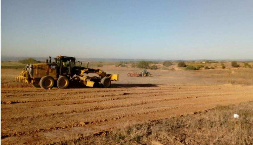
Travaux de préparation: aplanissement du terrain de 30 hectares
